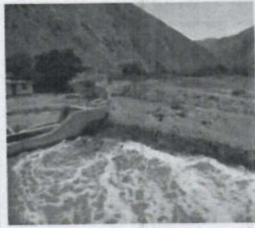
Barraje y ventana de Captación
