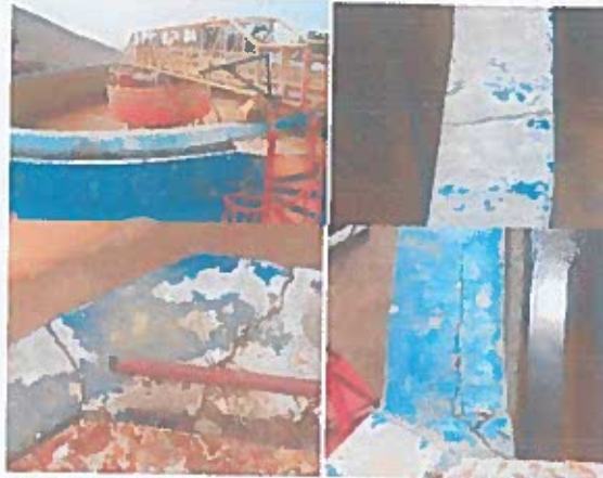
Figura 12: Turbo sedimentador B, forma de péndulo invertido, fisuras en el concreto perimetral PTAP 1 – Cata Catas
