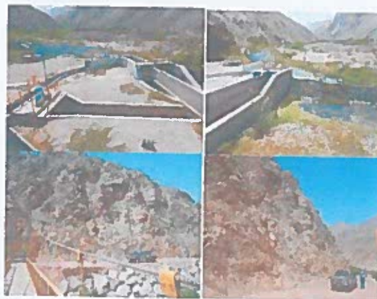
Figura 13: Bocatoma rio Osmore "El Canuto"
