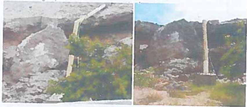
Cuadro 08: Vulnerabilidad del sistema de saneamiento de EPS ILO S.A
