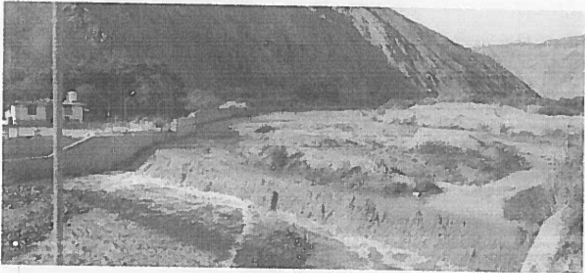
Captación Bocatoma "El Canuto"
