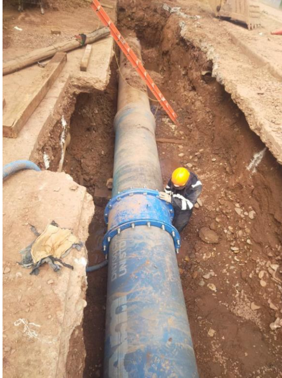
IMAGEN 11. LÍNEA DE INTERCONEXIÓN SISTEMA VILCANOTA EJECUTADO POR SEDACUSCO
