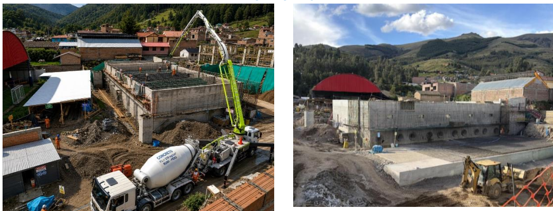
IMAGEN 15. CONSTRUCCIÓN DE LA PLANTA DE TRATAMIENTO DE AGUA POTABLE (PTAP) POR SEDAM HUANCAYO
