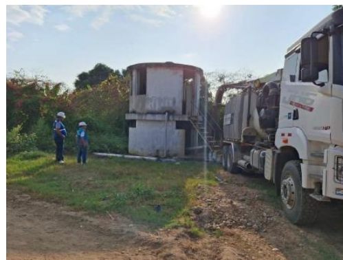
VERIFICACIÓN DEL EXTERIOR DEL MOTOR DE LA CÁMARA DE BOMBEO DE DESAGÜE – SAN JUAN DE LA VIRGEN
