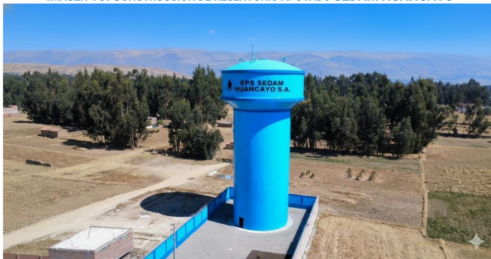
IMAGEN 16. CONSTRUCCIÓN DE RESERVORIO APOYADO SEDAM HUANCAYO
