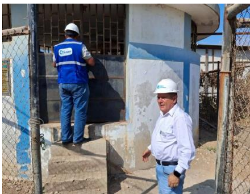
VERIFICACIÓN DEL EXTERIOR DEL MOTOR DE LA CÁMARA DE BOMBEO DE DESAGÜE – PUERTO PIZARRO
