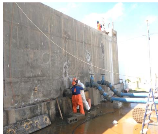
Mantenimiento R1 PTAP Cata Catas
