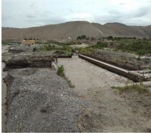
Desarenador y descarga de material de arrastre
