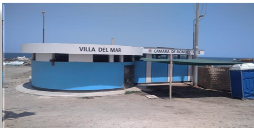
Estación de Bombeo con trabajos de Mejoramiento
