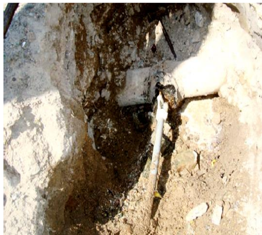
Fuga de Agua en Abrazadera
