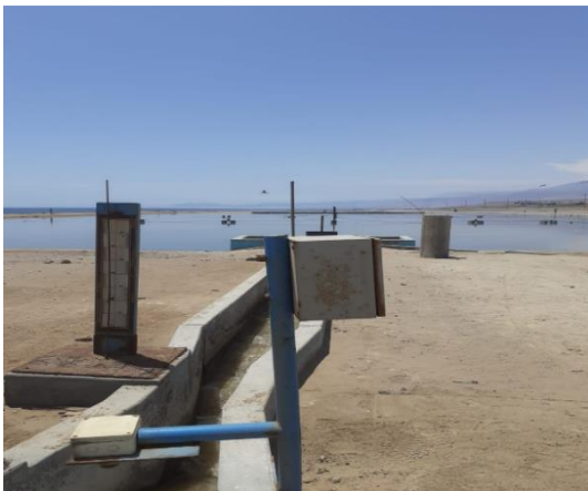
Sistema de medición - PTAR
