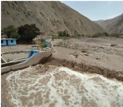
Barraje y ventana de Captación
