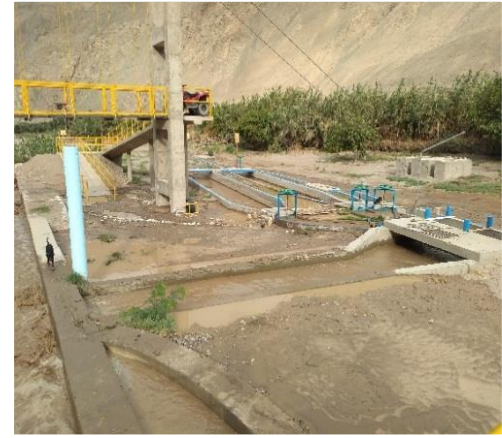
Puente, Desarenadores y Canal de Rebose
